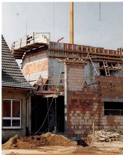
Anbau Vier-Klassen-Trakt: Fundament und Rohbau
