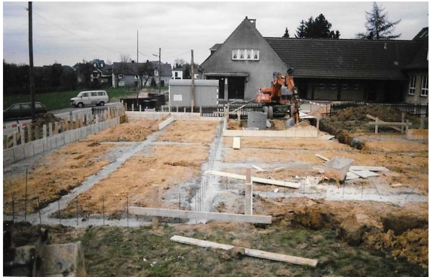
Das Fundament für den Pavillon – der erste Erweiterungsbau!
